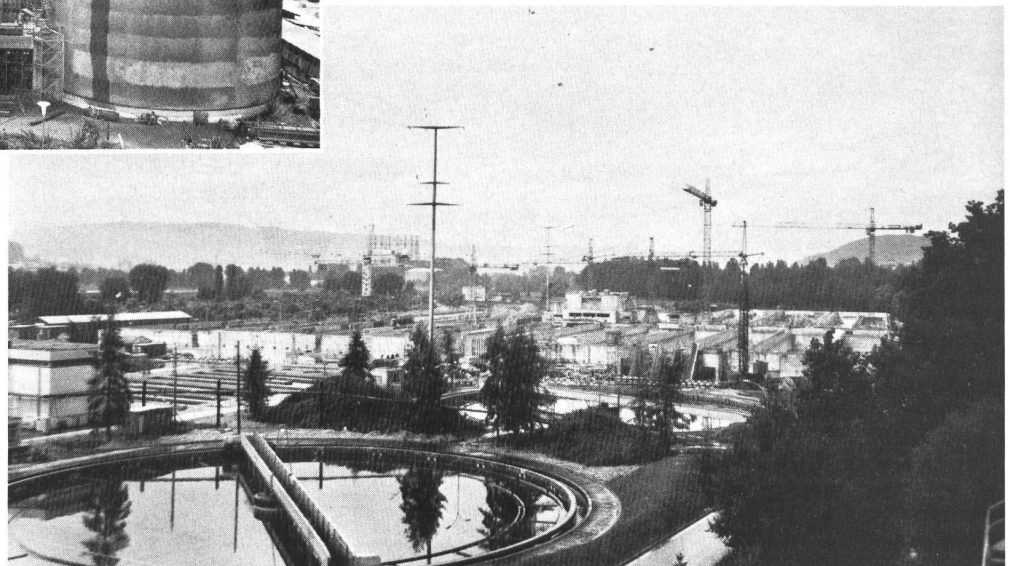
Blick über ein Nachklärbecken der bestehenden Anlage zur neuen biologischen Reinigungsstufe im Hintergrund.
