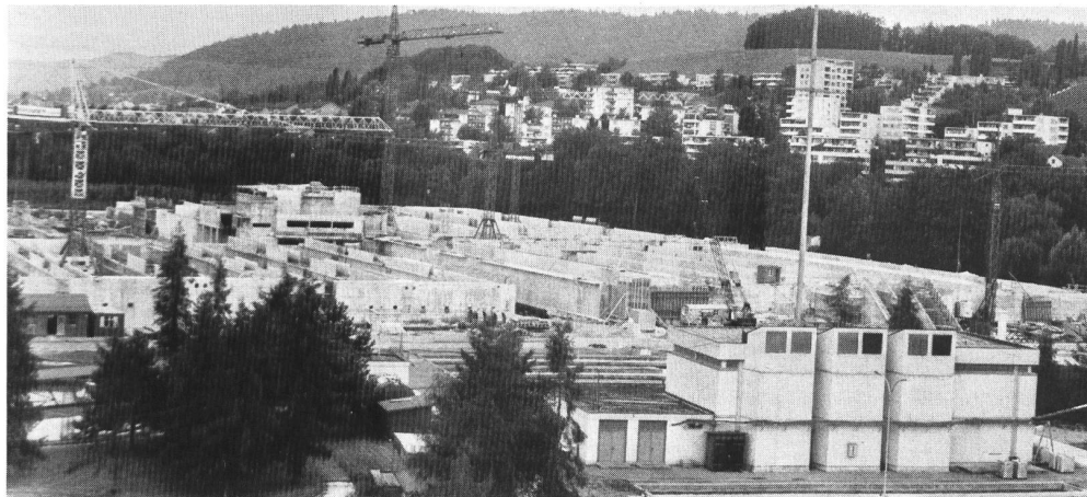
Im Vordergrund die Gebläsestation der bestehenden biologischen Reinigungsstufe. Dahinter die Becken der neuen Biologie mit dem Hochbau der Gebläsestation, dahinter die Filtration.
