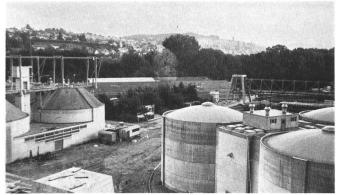
Links die Behälter der bestehenden Faulanlage, rechts davon die Behälter der Voreindickeranlage. In der Bildmitte das Dach der neuen Fahrzeugeinstellhalle und ein Teil der Stahlkonstruktion des rund 1 km langen Energiekanals, der über die gesamte Anlage führt.
