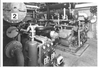
Abb. 5. Wärmepumpenanlage Leistung 900 kW.
