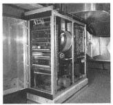
Solset-Wärmepumpenanlage mit 20 kW Heizleistung. Wärmequelle: Abluft der Sanitärräume.
