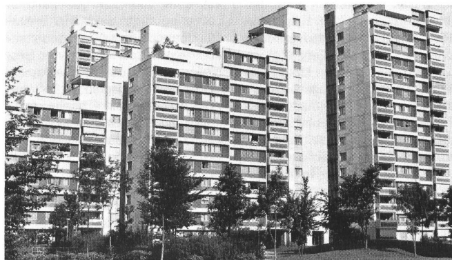
Überbauung im Murfeld, Bern, mit total 268 nachträglich eingebauten Fortluftautomaten.
