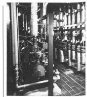
Gaswärmepumpenanlage zur Wärmegewinnung aus dem Hafenbecken.
