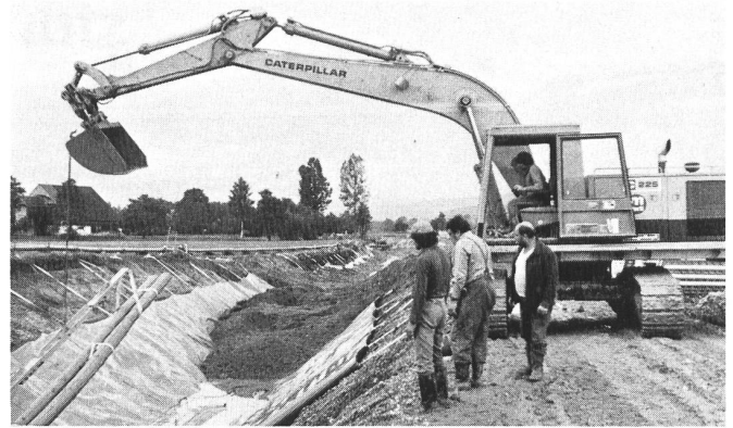
Abb. 5. Antransport einer Doppelrolle KDB und Absenken in Kanalachse.
