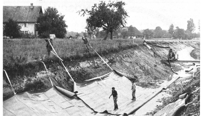
Abb. 8. Fixieren der Kunststoff-Dichtungsbahnen mit Hilfe der eingerollten Bänder. Die Bänder werden an vorher eingeschlagenen Pflöcken befestigt.
