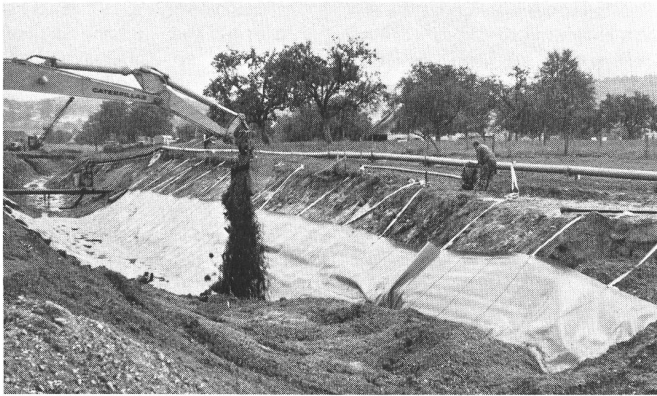
Abb. 9. Aufschütten von kiesigem Material auf die verlegten und verschweissten Kunststoff-Dichtungsbahnen. Um Überbeanspruchungen der KDB zu vermeiden, wird das Auffüllmaterial nicht direkt aus der Baggerschaufel auf die Dichtung geschüttet.
