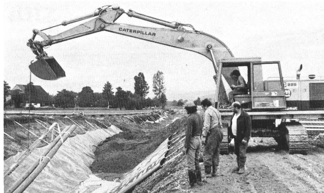
Abb. 5. Antransport einer Doppelrolle KDB und Absenken in Kanalachse.
