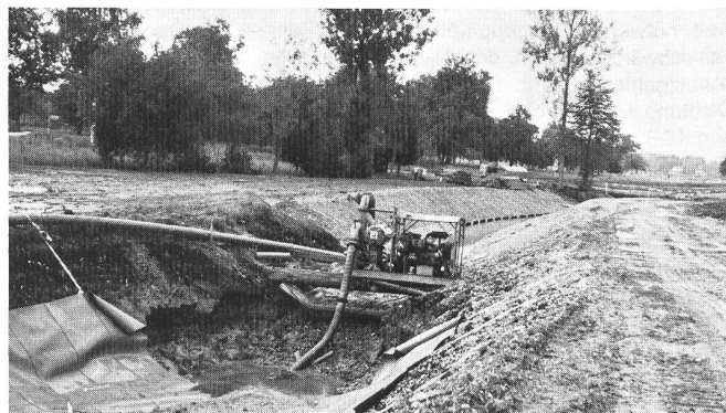
Abb. 12. Anfang der Abdichtungsstrecke mit dem KDB mit Pumpe für das Absaugen des von Oberstrom unter der KDB fliessenden Wassers. Im Hintergrund der fertige Kanal (ohne Dichtung). (Fotos Sarna Kunststoff AG, Sarnen)
