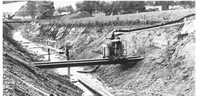
Abb. 6. Mit dem Bagger wird eine rund 10 m lange Kunststoff-Dichtungsbahn Sarnafil FP abgesenkt und in der Kanalachse verlegt. Die beiden Enden der Bahn ruhen nach dem Absenken auf vorher bereitgelegten Brettern, wodurch das nachfolgende Zusammenschweissen zweier Bahnen erleichtert wird.
