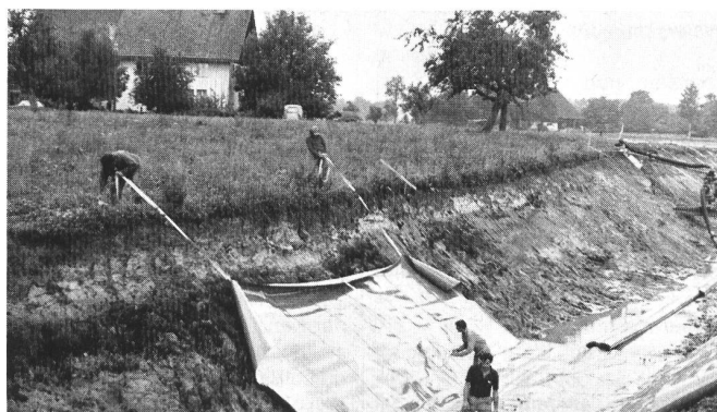
Abb. 7. Aufziehen der in der Kanalachse verlegten KDB mit Hilfe der eingerollten Bänder.
