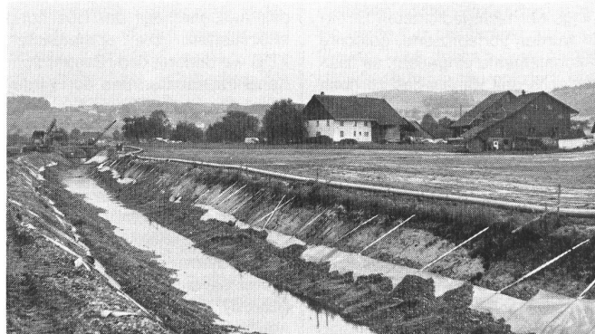
Abb. 10. Die Kunststoff-Dichtungsbahnen sind auf eine grössere Länge verlegt. Links das Naturschutzgebiet, rechts das landwirtschaftlich genutzte Gebiet. Am linken Ufer des Kanals eine Wasserleitung, die für die Überleitung des Grundwassers aus dem ausgehobenen und noch nicht gedichteten Teil des Kanals dient.
