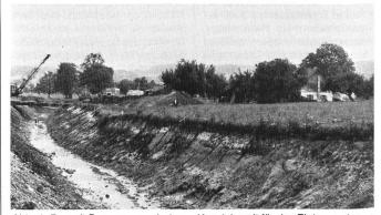
Abb. 1. Der mit Bagger ausgehobene Kanal, bereit für das Einlegen der Kunststoff-Dichtungsbahnen. Man beachte den sehr heterogenen Boden, in Bildmitte unten Bäume und Äste aus längst vergangenen Zeiten.
