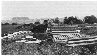
Abb. 2. Bereitgestellte vorfabrizierte Kanalelemente aus Beton, die direkt auf das mit dem Bagger eingebrachte Beschwerungsmaterial verlegt werden.
