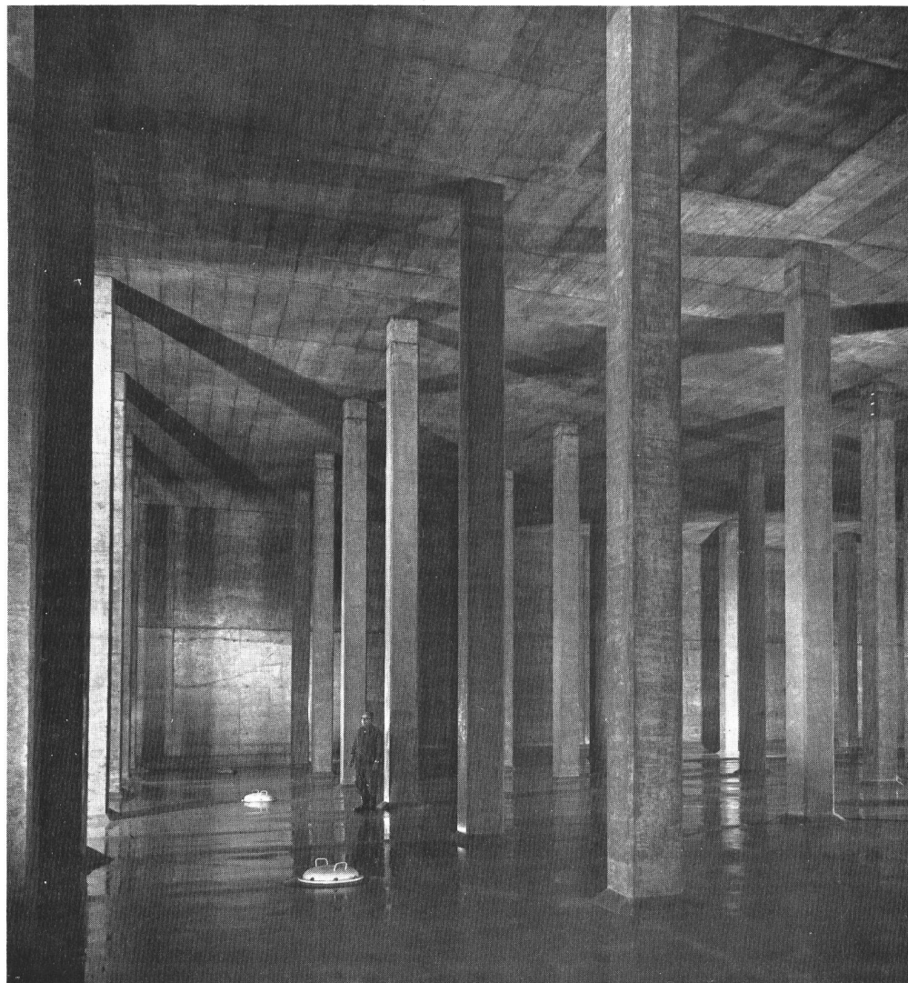
Abb. 5. Reservoir Lyren, Innenansicht einer Kammer mit 10000 m 3 Inhalt.
