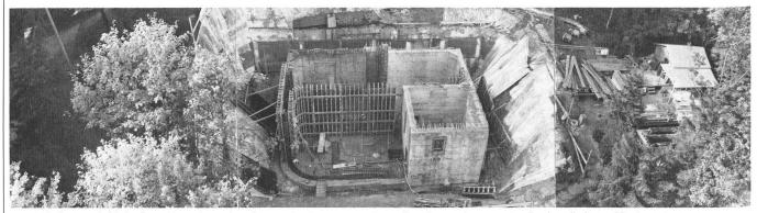
Abb. 13. Reservoir Ris im Bau, Abrundung einer Reservoirecke wegen späterer Terraingestaltung, rechts Bauinstallation auf Podest, darunter geschütztes Ried.
