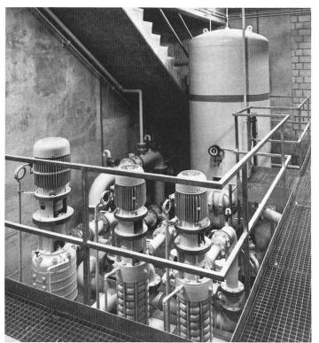
Abb. 6. Reservoir Waidberg (1980), Druckerhöhungsanlage für Gipfelzone Käferberg.
