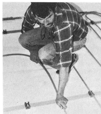
Die Unitherm-Fussbodenheizung wird im Schnellsteckverfahren verlegt.
