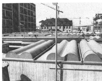
Abb. 8. Biologie: Entgasungszone und Nachklärbecken. Alle Anlagen werden aus Gründen der Betriebssicherheit dreistrassig geführt.
