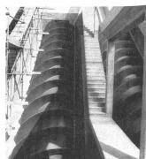
Abb. 3. «Schneckenpumpwerke», eine uralte und noch immer bewährte Konstruktion mit erstaunlichen Leistungen. Die vier Schnekken vermögen zusammen 9 m³ pro Sekunde zu fördern.
