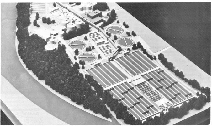
Abb. 1. Modellaufnahme der in die Belebungsstufe (unten) integrierten Abwasserfiltration. (Bild Sulzer)
