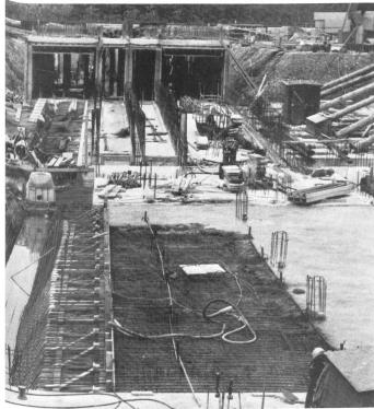
Abb. 6. Die Baustelle des Kellergeschosses der Filtration.
