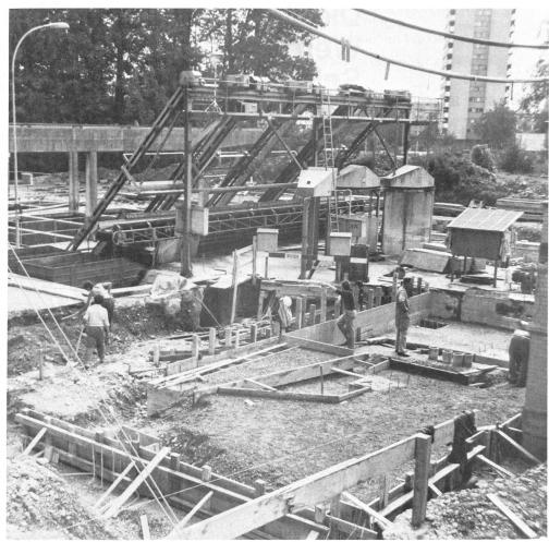
Abb. 2. Die Rechenanlage, welche im Zuge der Kläranlageerweiterung zur Vermeidung von Geruchsemissionen von einem Gehäude umschlossen wird
