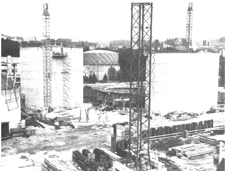
Abb. 8. Die vier neuen Behälter der Vorfaulanlage im Bau. Am rechten Bildrand ist ein Behälter der bestehenden Faulanlage sichtbar.
