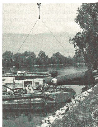
Die Lage des Dükers kann durch die an beiden Ufern stehenden Krane beeinflusst werden.
