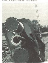
Das Dükerende mit den drei Anschlussflanschen für die Medienrohre.
