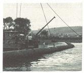
Der einbaubereite Düker wird schwimmend vom Montagedock aareaufwärts zur Einbaustelle gezogen.
