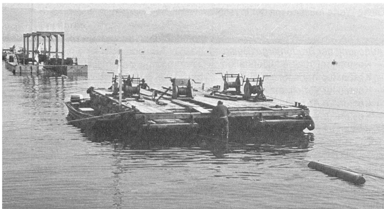
Verlegung der Zürichsee-Leitung.
