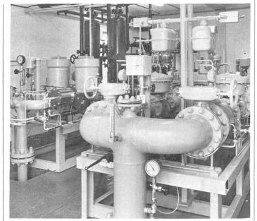
Innenansicht Gas-Druckreduzier- und Messstation Oberbuchsiten. Leistung bis 100 000 kW.
