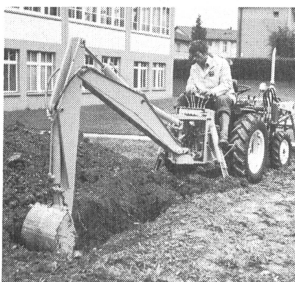
Arbeiten mit dem voll- hydraulischen Heckbagger
