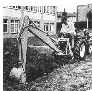
Arbeiten mit dem vollhydraulischen Heckbagger
