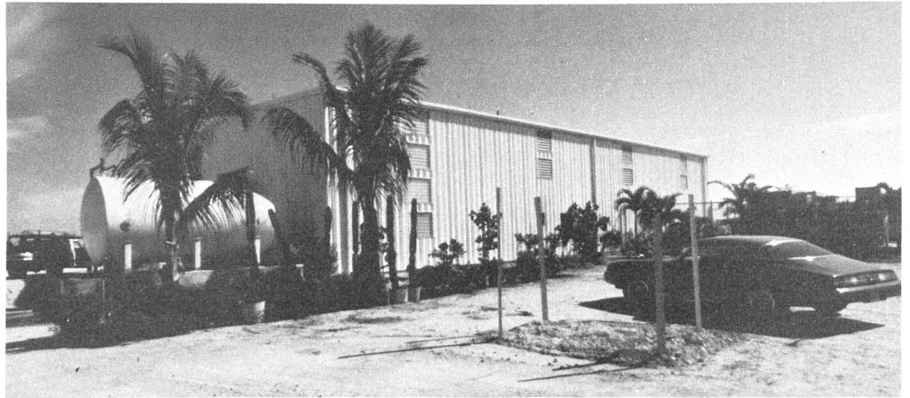
Die neue Umkehrosmoseanlage befindet sich auf Stock Island in der Nähe von Key West, Florida.
