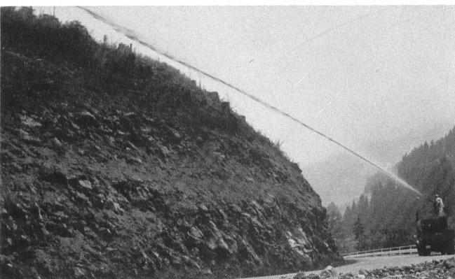
Hydraulische Begrünungen mit dem Hydro-Seeder sind auch in schwierigem Gelände und auf Rohböden möglich. Hier Ansaat mit der Distanzdüse.
