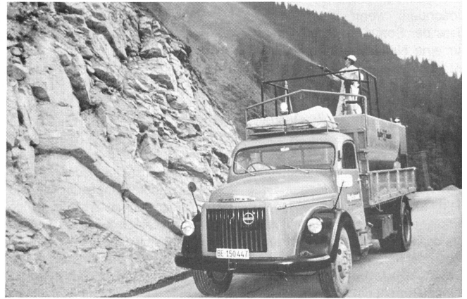
Hydraulische Ansaat mit dem Hydro-Seeder.
