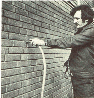
Thermoschaum wird in den Hohlraum zwischen den Mauerwerkschalen gespritzt.
