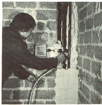
Schlitze und Kanäle werden mit Thermoschaum hohlraumfrei verfüllt.
