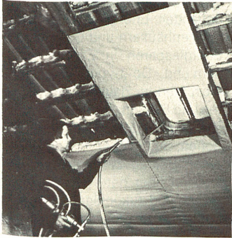
Bei Neubauten wird Thermoschaum hinter Unterspannbahnen gespritzt.
