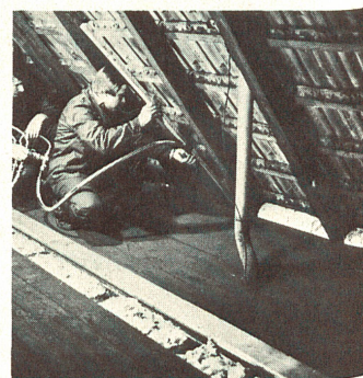
Nachträgliche Dämmung der Dachschrägen von der Kehlbalkendecke aus.
