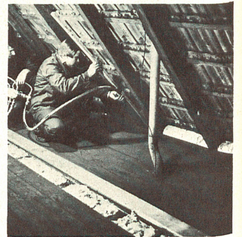
Nachträgliche Dämmung der Dachschrägen von der Kehlbalkendecke aus.
