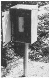
Abb. 4. Elektrische Niveaumessung und Registrierung mit Drucksonde in 160 m Tiefe, Messbereich 20 mWS.
