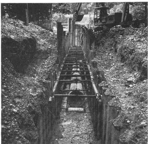
Abb. 3. Einzugschlitten mit montierten Rohren in der trockengelegten Montagegrube.
