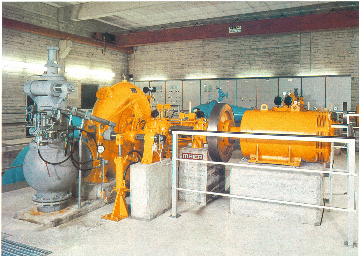
Abb. 3. Zwei Turbinenanlagen sind im Hochbehälter Lewerberg installiert. Abbildung 3 zeigt die Anlage I mit einer Generatorleistung von 400 kW. Links im Bild ist der hydraulisch arbeitende Druckregler erkennbar, der bei dem durch eine Schnellabschaltung der Turbine entstehenden Druckstoss eine Umgehung öffnet und so Schäden verhindert.
