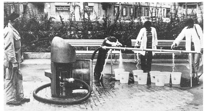
Abb. 17. Trinkwasserbrunnen mit eingebautem Hydranten. Er ist am separaten Brunnennetz für die Notwasserversorgung angeschlossen und ist daher ein Notstandsbrunnen.
