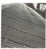
Niedertemperatur-Rohrkollektoren auf dem Hausdach geben Wärme an das Wärmepumpensystem ab.
