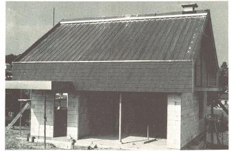
Abb. 1. Das integrierte Energiedach «Sessa-Therm».
