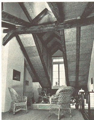
Schichtex-Spezial 100/III, mit Längsfalz, in Speziallängen, Breite 62,5 cm, Sichtseite roh, auf Holzsparrnen verlegt.
