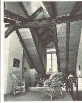
Schichtex-Spezial 100/III, mit Längsfalz, in Speziallängen, Breite 62,5 cm, Sichtseite roh, auf Holzsparren verlegt.
