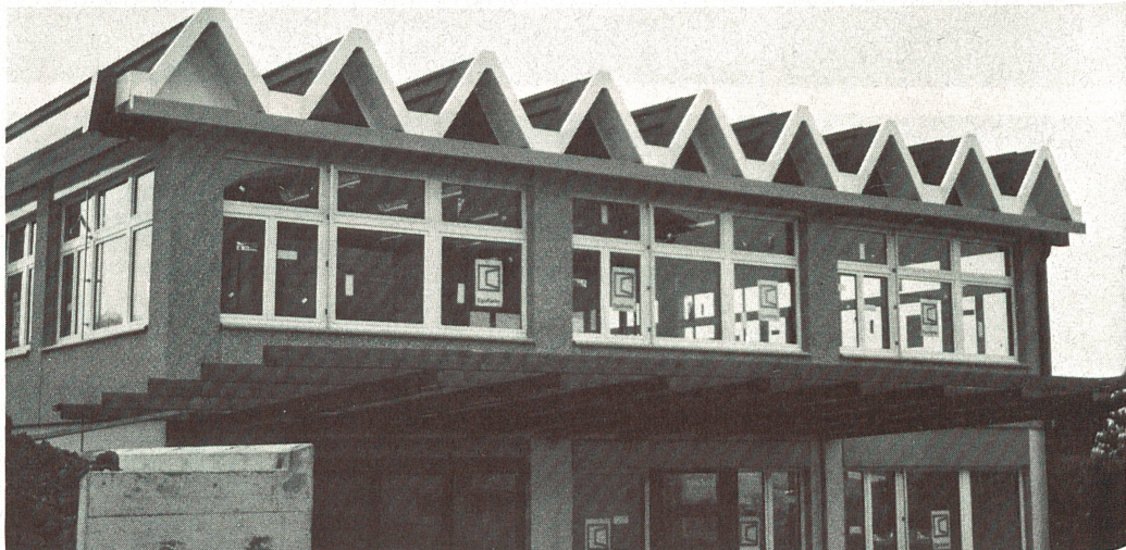
Beispiel Fabrikhalle in Wädenswil.
