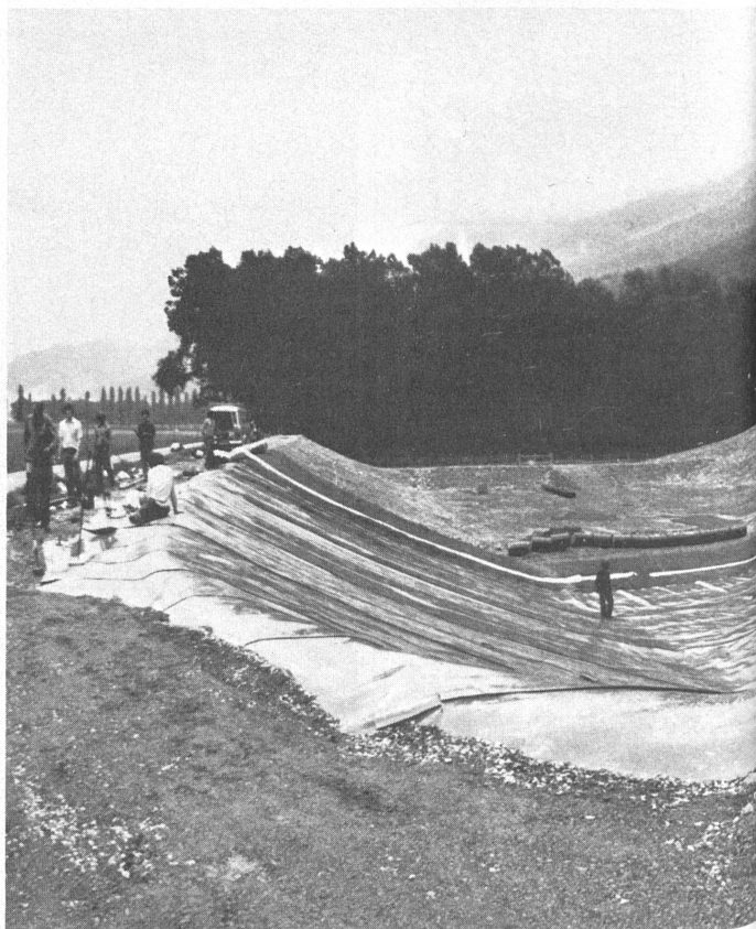
Blick auf die erste mit KDB gedichtete Etappe der zukünftigen Deponie. Im Vordergrund sowie links und rechts das Planum der zukünftigen Zufahrtsstrassen.
