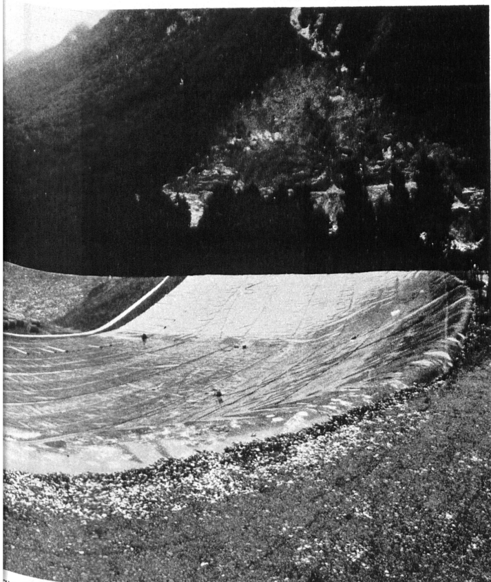
Die KDB wird von der Sarna Kunststoff AG in Monthey während den Verlege- und Schweissarbeiten. von denen aus die Deponie gefüllt wird. (Foto: Ciba-Geigy AG, Monthey).
