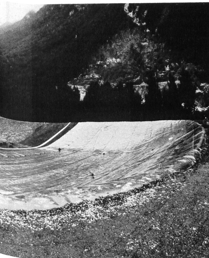
by AG in Monthey während den Verlege- und Schweissarbeiten. von denen aus die Deponie gefüllt wird. (Foto: Ciba-Geigy AG, Monthey).
