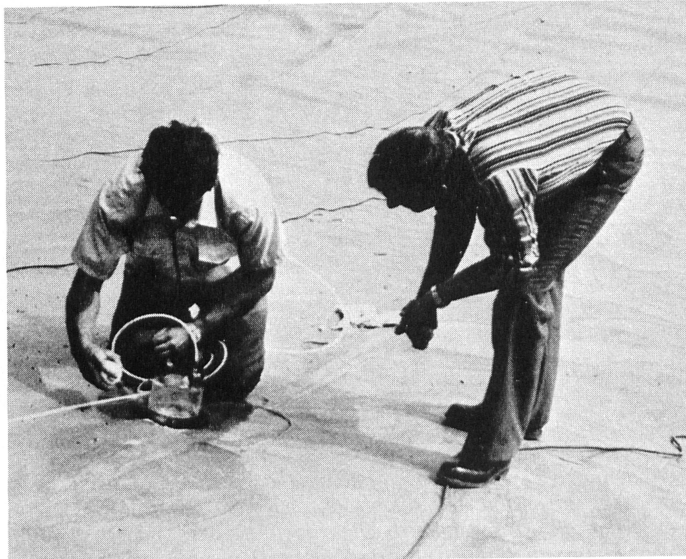
Die mit dem Heizkeil-Schweissapparat erzeugten Doppelnähte werden mit einem Luftdruck von 2 bar geprüft. Sinkt der Druck nach 15 Min. um nicht mehr als 0,1 bar ab, so ist die Prüfung bestanden. Fehlstellen, die sehr rasch aufgefunden werden können, werden ebenfalls mit KDB nachträglich mit Hilfe eines Handextruders saniert. Diese Schweissnähte werden mit der Vakuumhaube geprüft. Undichtigkeiten zeigen sich durch Blasenbildung im aufgespritzten Lecksuchspray an. (Foto: Sarna Kunststoff AG in Sarnen).
