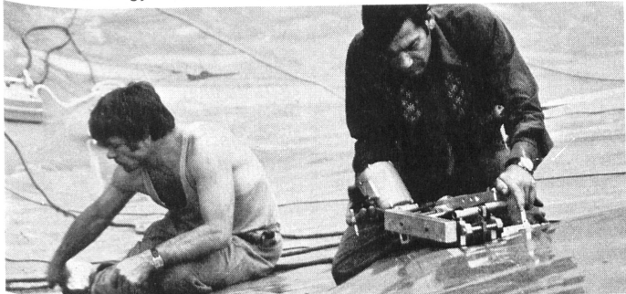
Verschweissen der ausgelegten KDB mit dem von der Sarna Kunststoff AG entwickelten automatisch arbeitenden Heizkeil-Schweissapparat, mit dem zwei nebeneinanderliegende Schweissnähte mit dazwischenliegenden Prüfkanal erzeugt werden. Anschliessend werden die Schweissnähte auf Dichtigkeit und mechanische Widerstandsfähigkeit geprüft. (Foto: Ciba-Geigy AG, Monthey).
