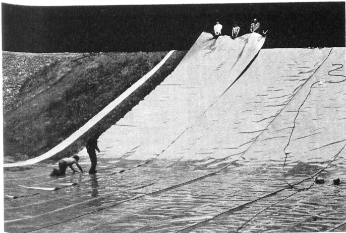
Auslegen der 4,20 m breiten und 51,50 m langen KDB aus Hochdruck-Polyäthylen (Sarnafil FP) grün durchgefärbt auf die vorbereiteten Flächen des Bodens und der Böschung in der zukünftigen gesicherten Deponie. (Foto: Ciba-Geigy AG, Monthey).
