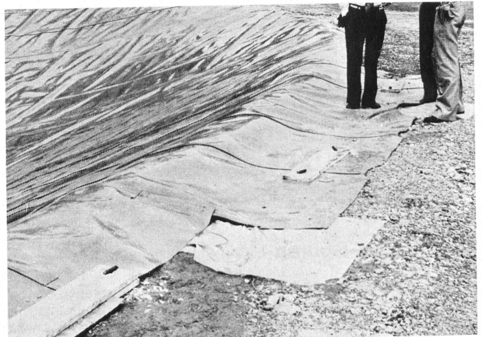
Die ausgelegten KDB aus Hochdruck-Polyäthylen (LDPE) werden auf der Dammkrone mit Hilfe von Brettern und durchgestossenen, in das Erdreich reichenden Eisennägeln befestigt. (Abb.: Sarna Kunststoff AG, Sarnen).
