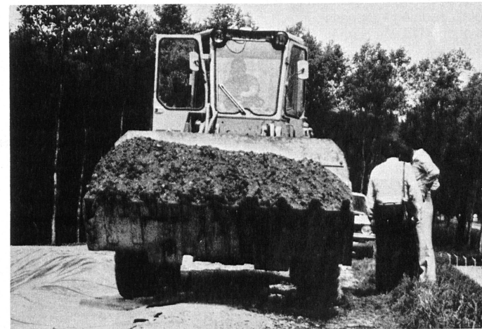
Praktische Demonstration der Flächendruckfestigkeit und hohen Durchstossfestigkeit der 2 mm starken KDB Sarnafil FP. Der Pneulader fährt ohne weiteres über die auf Kiesboden lose verlegte KDB hinweg, ohne dass diese irgendwie beschädigt wird. (Foto: Sarna Kunststoff AG, Sarnen).
