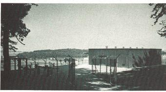
Druckreduzier- und Messstation der Frigaz in Givisiez FR. Links der Streckenschieber mit ferngesteuerten Schützen. Drei weitere solche Stationen sind für die Unigaz-Leitung in Pomy bei Yverdon, in Curtilles bei Lucens und in Schleifacker bei Bern gebaut worden. Ihre Kapazität variiert zwischen 2500 und 20000 m³ (n)/h.
