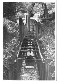
Abb. 3. Einzugschlitten mit montierten Rohren in der trockengelegten Montagegrube.
