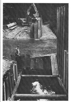
Abb. 1. Montagegraben an den beiden Tössufern.
