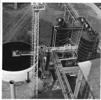
Aufbereitungsstation für Schlamm, Abwasser und flüssige Rückstände.
