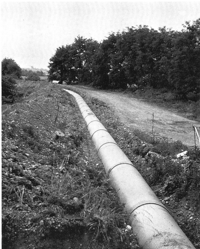
Druckleitung Ø 1000 mm, PN 4
