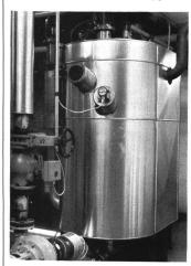
Sulzer-Schlamm-Schlamm-Wärmetauscher für optimale Energieausnutzung bei der Klärschlamm-Vorpasteurisierung.
