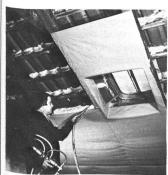
Bei Neubauten wird Thermoschaum hinter Unterspannbahnen gespritzt.
