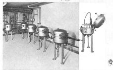
Ausschnitt aus einer Gruppe von 11 Entkeimungsfiltern MF 31, Mineralquelle Eglisau, Leistung: 1000 l/min.
