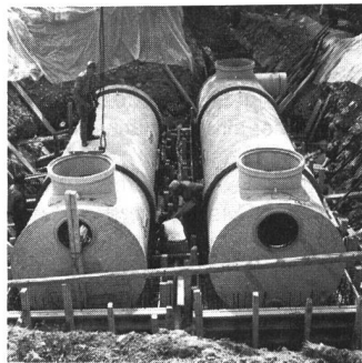
Abb. 1. Vorfabrizierte Regenwasser-Rückhaltebecken «Eternit» erfordern minimale Baustelleninstallationen und zeichnen sich durch rasche Montage aus.
