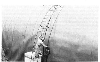
Detailbild des Verschweissens einer Quernaht zwischen den je 5,6 m breiten und 39,5 m langen, 4 mm starken Dichtungsbahnen aus Polyäthylen (Foto: Sarna Kunststoff AG, 6060 Sarnen).
