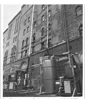
Das völlig neu konstruierte Staubabscheidesystem arbeitet nach dem Grundprinzip der «gesteuerten Arbeitsplatzventilation». Das System besteht aus einem Hochdrucksaugaggregat im Bildvorderteil und einem Ventilationsaggregat hinten im Bild in Kombination mit Vorabscheidern und festem Rohrsystem. Deutlich sichtbar sind die beiden Rohrleitungen an der Fassadenaussenseite mit Abzweigungen zu den einzelnen Stockwerken.
