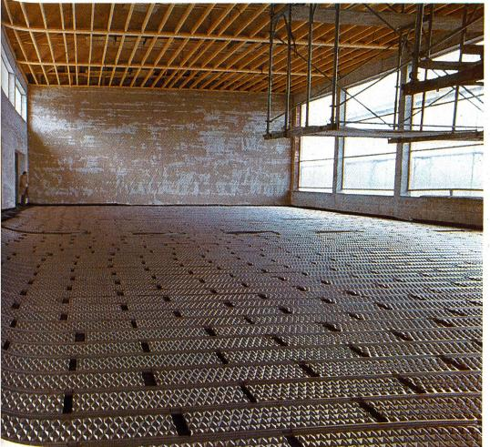
Abb. 1. PYD-System mit Wärmeleitblechen
