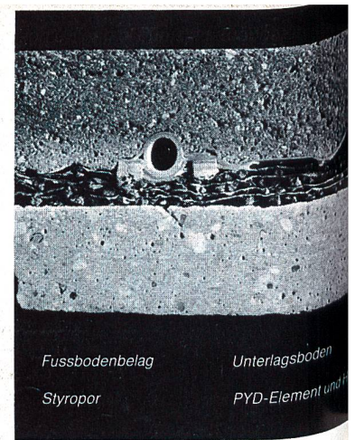
Abb. 3. Fussbodenaufbau
