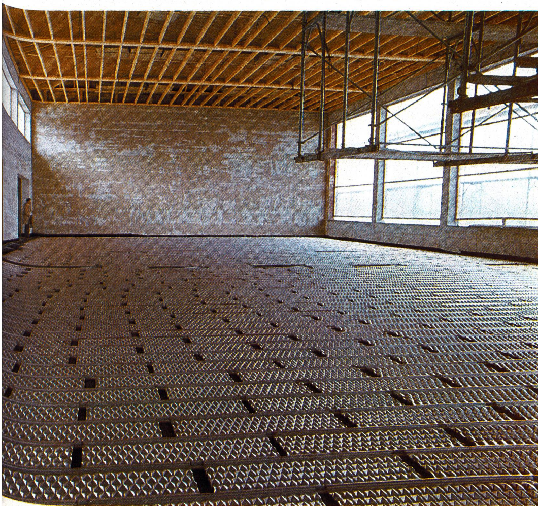
Abb. 1. PYD-System mit Wärmeleitblechen
