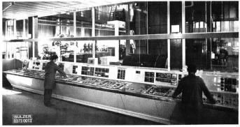
Blick vom Kontrollraum in die Heizkraftzentrale des Flughafens Zürich-Kloten. Die Zentrale umfasst zwei Sulzer-Dampferzeuger von je 12 t/h und 13 bar sowie drei Dampferzeuger mit einer Leistung von 25, 30 und 80 t/h bei 80 bar und 475°C.
