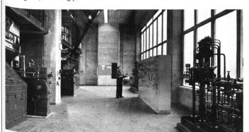
Kohle- und ölgefeuerte Sulzer-Dampferzeuger, Leistung je 40 t/h bei 66 bar und 475°C, Baujahr 1961, im Fernheizkraftwerk der Stadt Bern.
