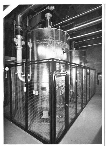
Zwei Sulzer-Elektrokessel von je 10 MW für die Wärmeversorgung eines Druckereizentrums in Stuttgart.
