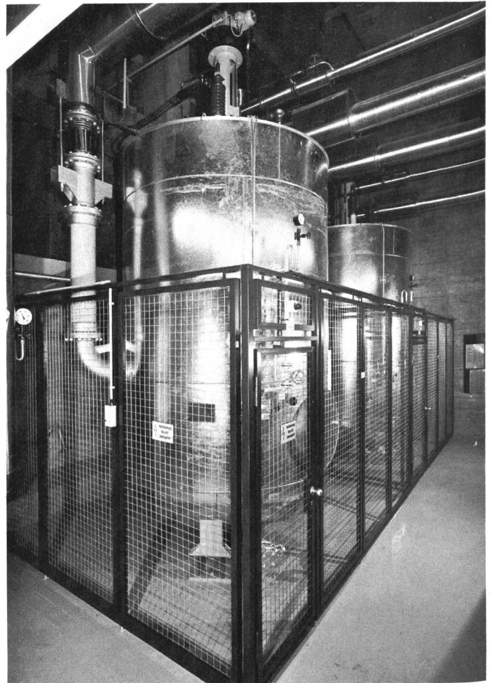
Zwei Sulzer-Elektrokessel von je 10 MW für die Wärmeversorgung eines Druckereizentrums in Stuttgart.
