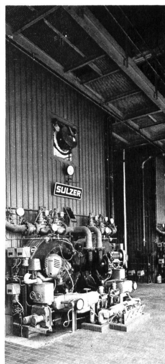
Heizkraftwerk des Kantonsspitals Genf mit zwei Sulzer-Heisswasserkesseln von je 29 MW und zwei Dampfkesseln von je 30 t/h bei 79 bar und 475 °C.
