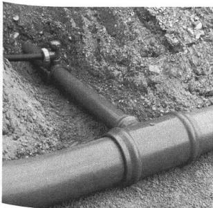
Neu für die Wasserversorgung: Steckmuffenfittings von +GF+ aus PVC. Oder einfach STEMU-Fittings. Rasch und einfach verlegt – deshalb eine wirtschaftliche Rohrverbindung für die Wasserversorgung.
