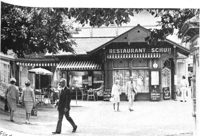
Für das Image des Kurortes wichtige Holzarchitektur des ausgehenden 19. Jahrhunderts. Die wenigen noch erhaltenen Objekte sind erheblich gefährdet.
