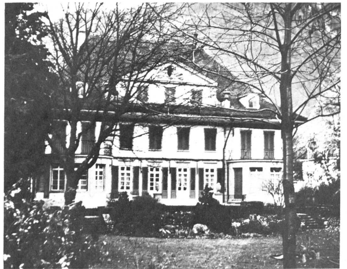
Für die «Villa Cranz», einst Sitz von General Guisan, welche veräussert und einem Neubau weichen sollte, konnte eine Lösung gefunden werden. Die Gemeinde kaufte 1978 die ganze Liegenschaft und richtete dort die Gemeindeverwaltung ein. Dadurch bleibt auch der schöne Park der Öffentlichkeit erhalten.
