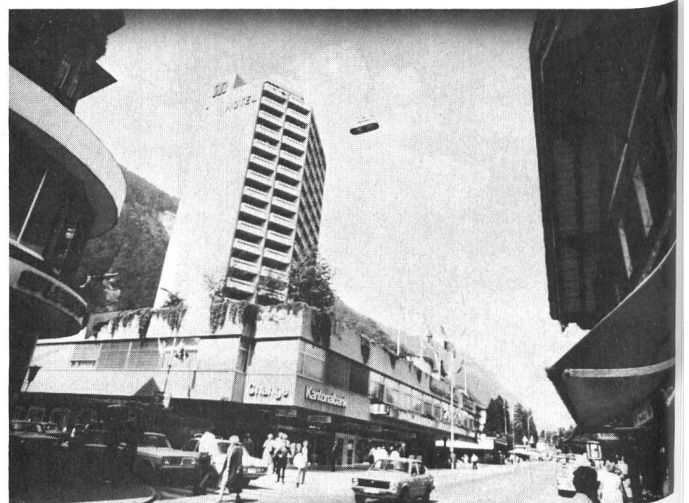
Das Hotel Metropole – Symbol für die neuere Bauentwicklung.
