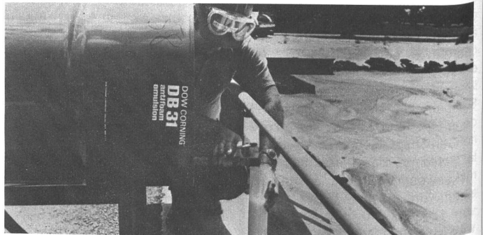
Ein Techniker der BASF-Kläranlage in Louisiana, USA, entnimmt eine kleine Menge des Siliconentschäumers Dow Corning® DB-31 aus einem Behälter seitlich des Durchlüftungsbeckens. Rechts im Bild die Schaumansammlung an der Beckenoberfläche.
