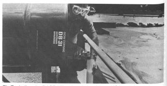
Ein Techniker der BASF-Kläranlage in Louisiana, USA, entnimmt eine kleine Menge des Siliconentschäumers Dow Corning® DB-31 aus einem Behälter seitlich des Durchlüftungsbeckens. Rechts im Bild die Schaumansammlung an der Beckenoberfläche.
