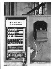
Einbaublock mit Wärmepumpe und Steuerung (links), daneben der Einbaublock mit Kessel, Feuerung, Speicher und Boiler.
