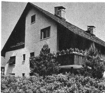
Wohnhaus über dem Zürichsee. Bei diesem Objekt wurde das individuelle Aussehen mit energieeinsparendem Baustoff realisiert. Die Außenwandkonstruktion aus Siporex hält im Winter die Wärme zurück. Die kleindimensionierte Heizanlage ist mit einem Schiedel-Isolierkamin ausgestattet.
