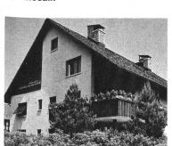
Wohnhaus über dem Zürichsee. Bei diesem Objekt wurde das individuelle Aussehen mit energieeinsparendem Baustoff realisiert. Die Aussenwandkonstruktion aus Siporex hält im Winter die Wärme zurück. Die kleindimensionierte Heizanlage ist mit einem Schiedel-Isolierkamin ausgestattet.
