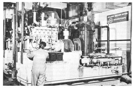
heizeinrichtungen für die Behandlung der Hallenluft, damit im Dachbereich der Eishalle keine Kondenswasserbildung auftritt. Um den ganzjährigen Eislaufbetrieb zu gewährleisten, wurden zwei ölfrei verdichtende Sulzer-Labyrinthkolben-Kompressoren für eine Kälteleistung von je 690 kW ausgelegt. Damit wird auch bei extremen Aussentemperaturen eine konstante Eisqualität erreicht. Die Kompressoren sind direkt mit 110-kW-Gasmotoren gekop-
