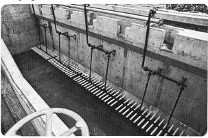
Ausschwenkbare Belüftungseinrichtung (ARA, Wartau/SG)
