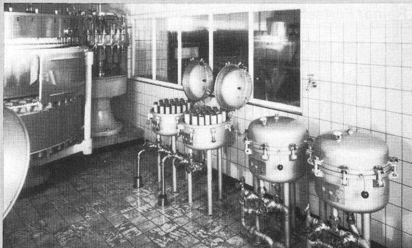
Katadyn-Filtergruppe Typ MF-31 für Wasser-Entkeimung
