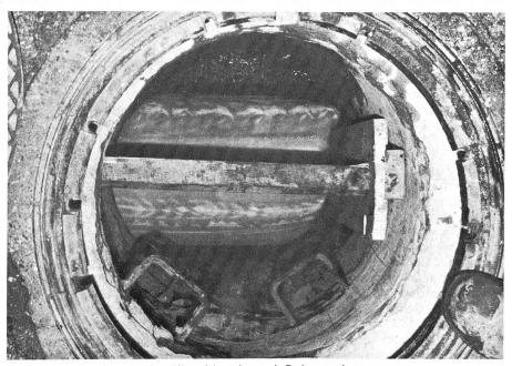
Abb. 2. Imprägnierung des Filzschlauches mit Polyesterharz.
