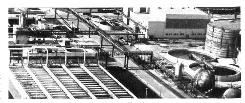
Die zweite Ausbaustufe der Bio-Anlage in Hoechst: abgedeckte Vorklärung, Belebungsbecken mit Maschinenhaus und Druckluftzuführung, Nachklärbekken (teils verdeckt), Neutralisation, Schlammeindicker (Rundbecken), Filtergebäude zur Schlammentwässerung.
