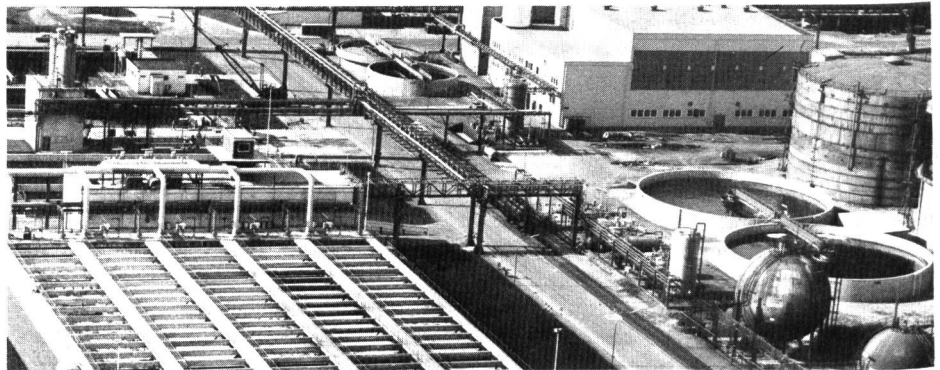
Die zweite Ausbaustufe der Bio-Anlage in Hoechst: abgedeckte Vorklärung, Belebungsbecken mit Maschinenhaus und Druckluftzuführung, Nachklärbecken (teils verdeckt), Neutralisation, Schlammmeindicker (Rundbecken), Filtergebäude zur Schlammmentwässerung.
