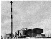
nungslinien zu 180 t/24 h und der modernsten Rauchgasreinigungsanlage. Die Wärmeverwertung erfolgt in Form von Schlammtrocknung und -verbrennung (Jahreskapazität ca. 20 000 t vorentwässerten Schlamms mit 75 % Wassergehalt).
