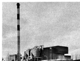
nungslinien zu 180 t/24 h und der modernsten Rauchgasreinigungsanlage. Die Wärmeverwertung erfolgt in Form von Schlammtröcknung und -verbrennung (Jahreskapazität ca. 20 000 t vorentwässerten Schlamms mit 75 % Wassergehalt).
